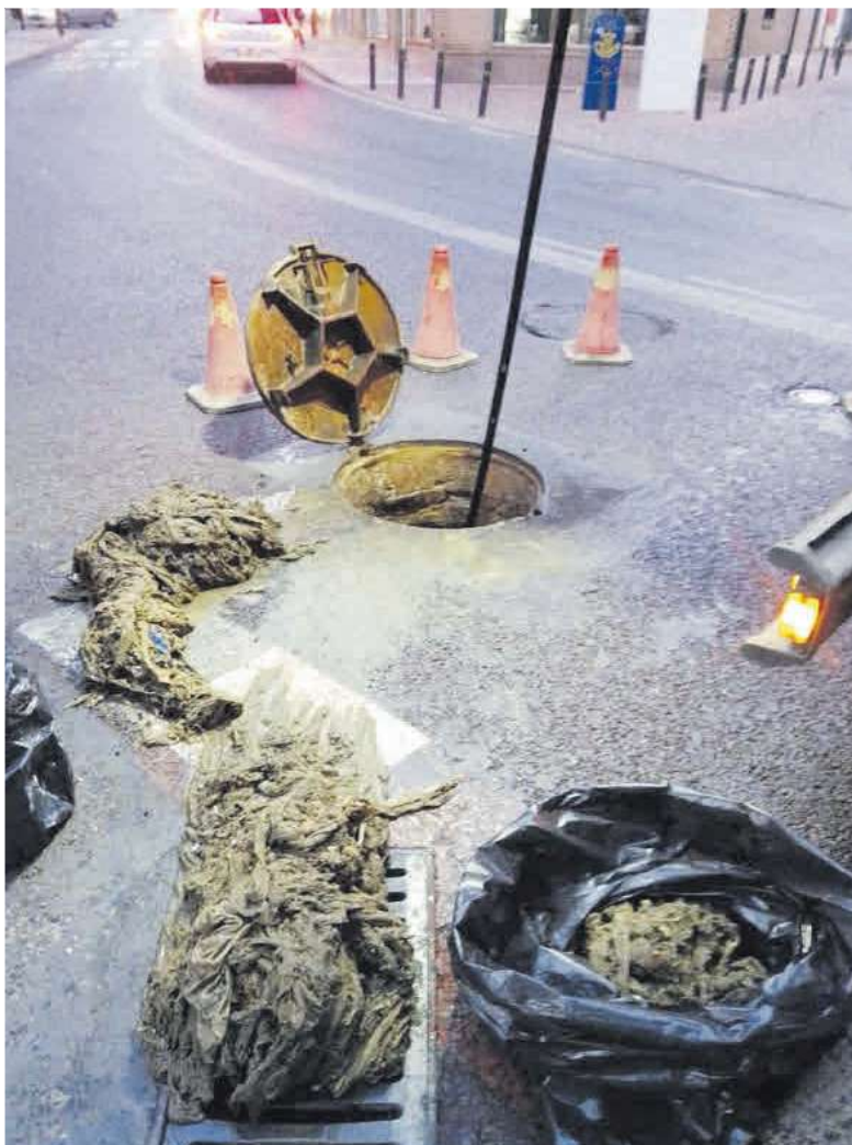
Técnicos de Aguas de Murcia realizan labores preventivos y de limpieza en la red de alcantarillado municipal.
